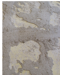
Die Rückseite der von der Wand abgelösten Malschicht.
