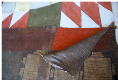
Die Rückseite der von der Wand abgelösten Malschicht.
