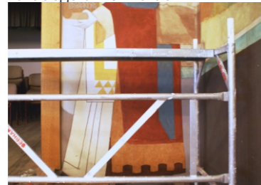
Detail Transfert Wandbild: Die Malschicht wird mit Leinwand auf löslichem Leim abgedeckt und von der Wand gelöst.
